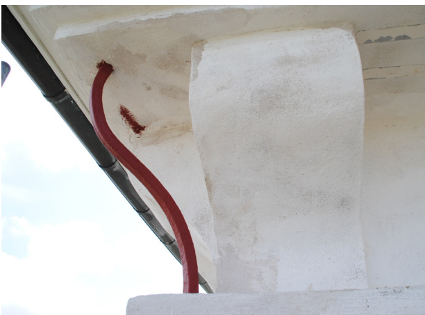
De stödjande hörnjärnen i takgesimsen har rengjorts från rost och rostskyddsmålats.
