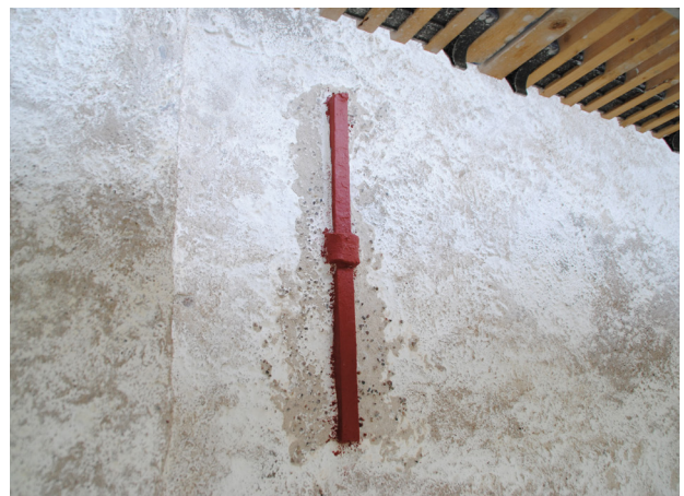
Samtliga dragjärn på tornet har knackats rena från puts, rengjorts från rost och rostskyddsmålats.
