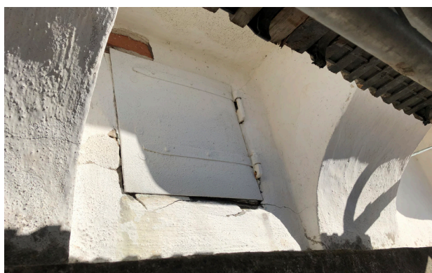
Ovan till vänster och ovan: Den nedre gördelgesimsen hade stora putsskador både över och på listens profiler. Plåtavtäckningen saknade en fungerande putskant. Den övre gördelgesimsen av natursten behövde fogas om.
