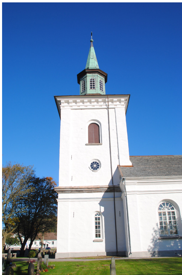
Tornets södra fasad efter renovering.
