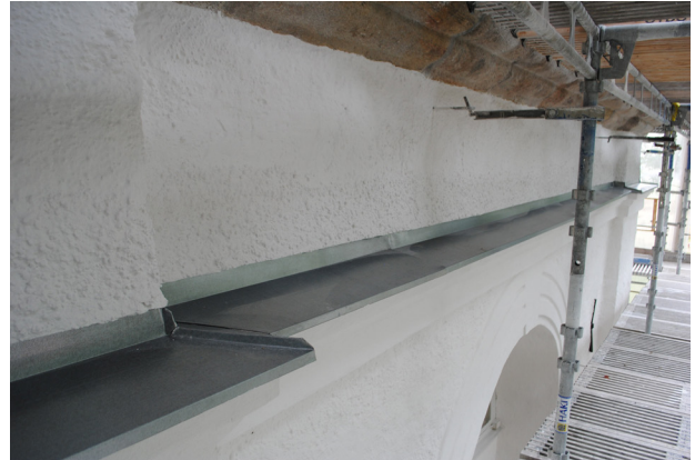
Ny plåttäckning med putskant har lagts på gördelgesimsen. Väggen över har putsats om.
