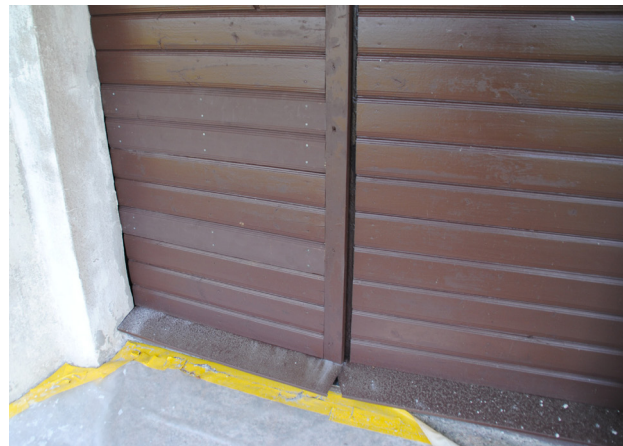
Karmen har reparerats. Plåtavtäckningen i nederkanten var i dåligt skick och fick bytas.
