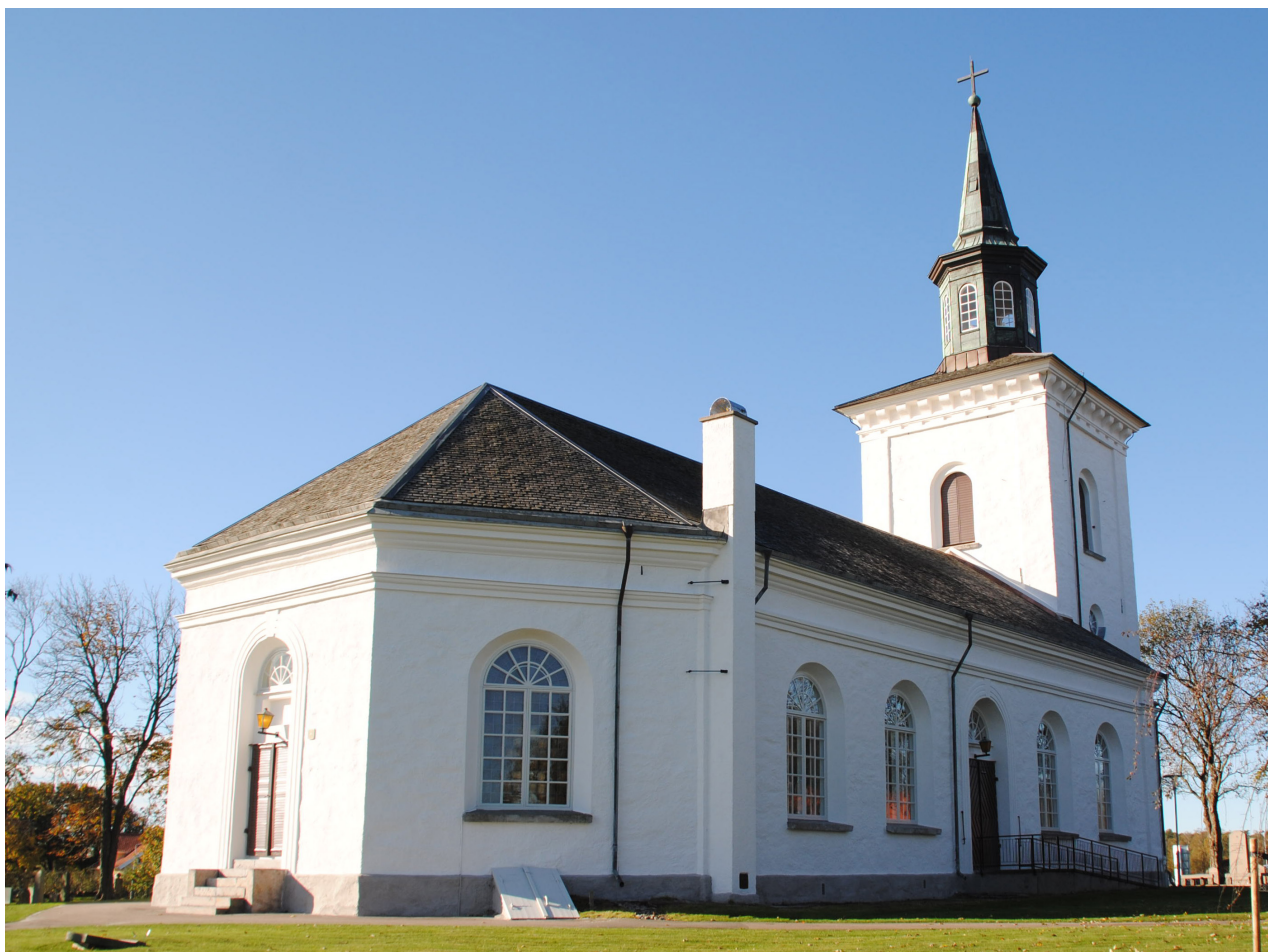
Östra och norra fasaderna efter renovering.
