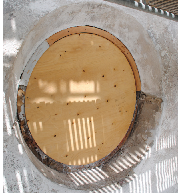
Karmen har reparerats. Plåtavtäckningen i nederkanten var i dåligt skick och fick bytas.
