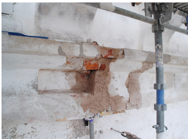
Takgesimsen murades upp igen med tegelsten.
