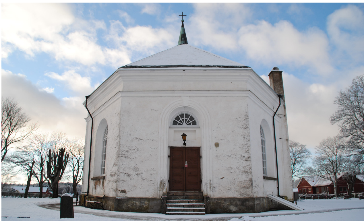
Östra fasaden hade före renoveringen putsskador och påväxt av alger. Socken var mycket skadad och missfärgad.
