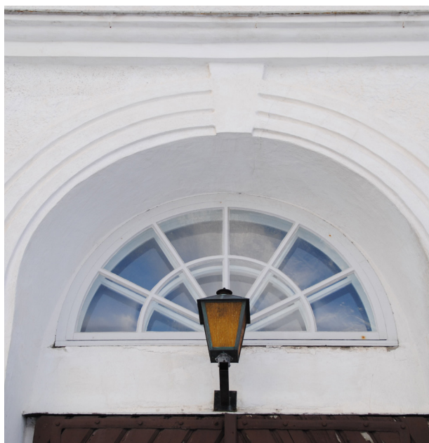
Över södra och norra entréerna finns halvrundera fönster.
