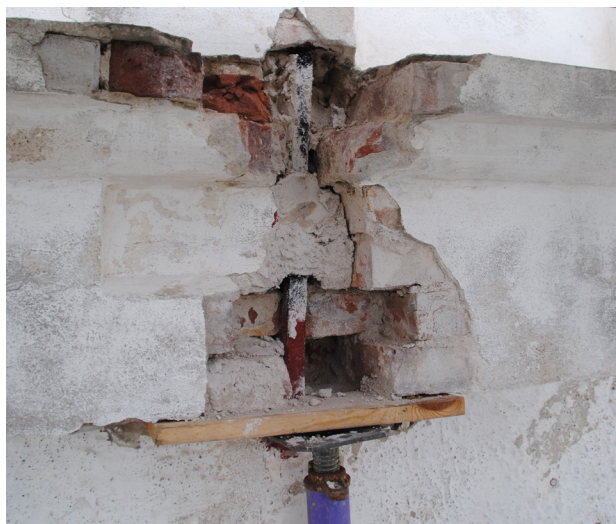
Ovan: De inmurade dragjärnen i takgesimsen togs fram och rengjordes från rost.
