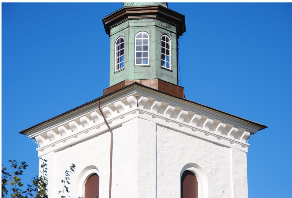
Övre delen av tornet efter renovering. De stora skadorna på takgesimsen har åtgärdats.
