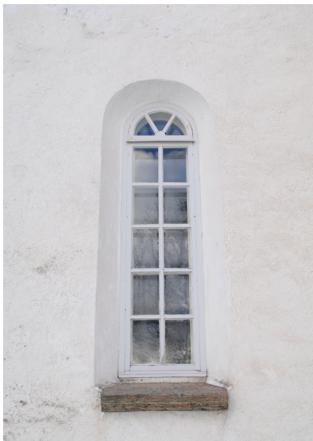
Ett av de två smala spröjsade fönster i tornet före renovering.
