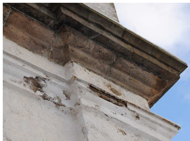
Ovan till vänster och ovan: Den nedre gördelgesimsen hade stora putsskador både över och på listens profiler. Plåtavtäckningen saknade en fungerande putskant. Den övre gördelgesimsen av natursten behövde fogas om.
