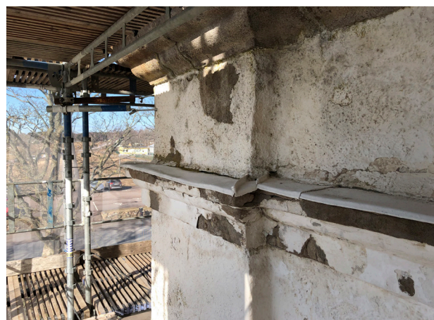
Skadorna i takfoten på tornets västra sida har tidigare reparerats från lift, men putsbitar hade börjat lossna igen.
