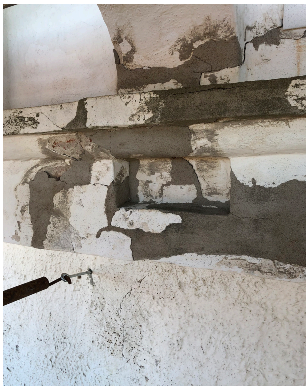
Skadorna i takfoten på tornets västra sida har tidigare reparerats från lift, men putsbitar hade börjat lossna igen.
