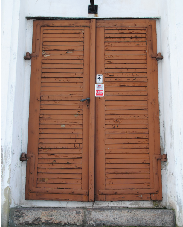
På sakristiedörren i öster flagnade färgskiktet och när renoveringen av dörren påbörjades upptäcktes att det även fanns mycket rötskador på panelen.
