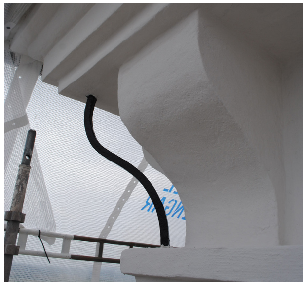
Ovan och till vänster: Allt smide har slutstrukits med svart linoljefärg. Putsen går inte längre upp på ankarjärnen.
