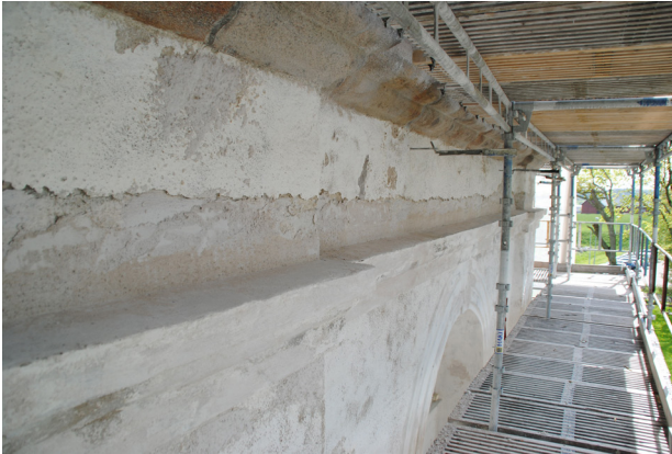
På den nedre gördelgesimsen revs plåten och den dåliga putsen på väggen över knackades ner.
