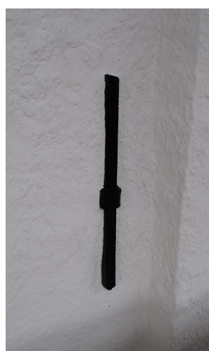
Ovan och till vänster: Allt smide har slutstrukits med svart linoljefärg. Putsen går inte längre upp på ankarjärnen.
