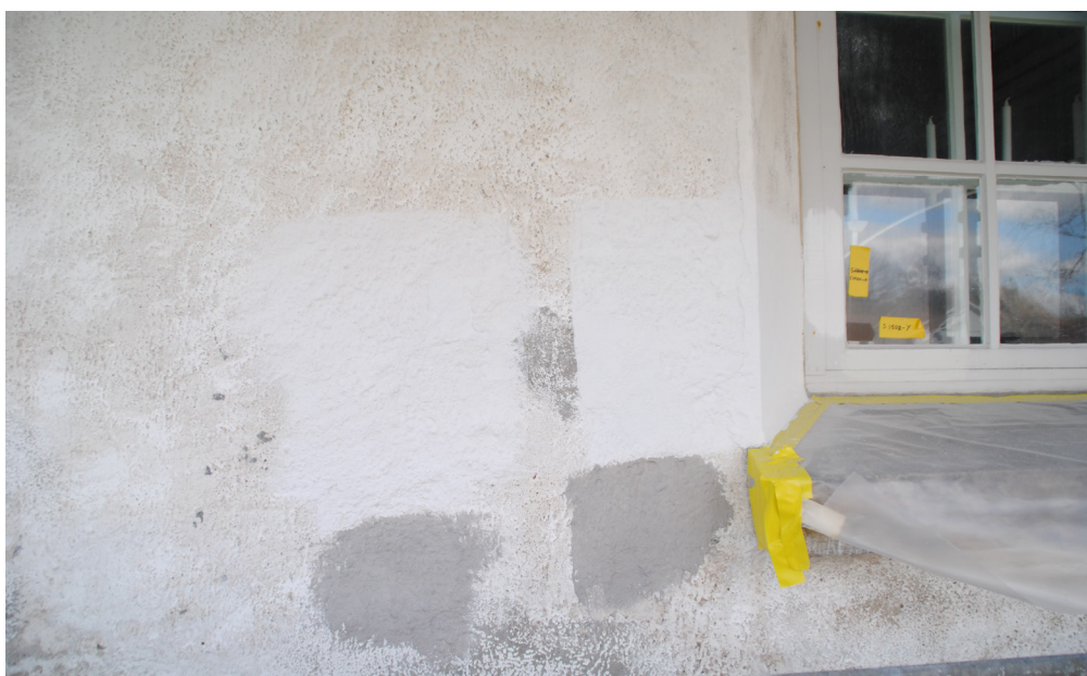
Flera provmålningar gjordes för hitta rätt kulör på fasad- och sockelfärg. Valet föll till slut på kulörerna 88H66 och 187 PQ ur Keims sortiment.
