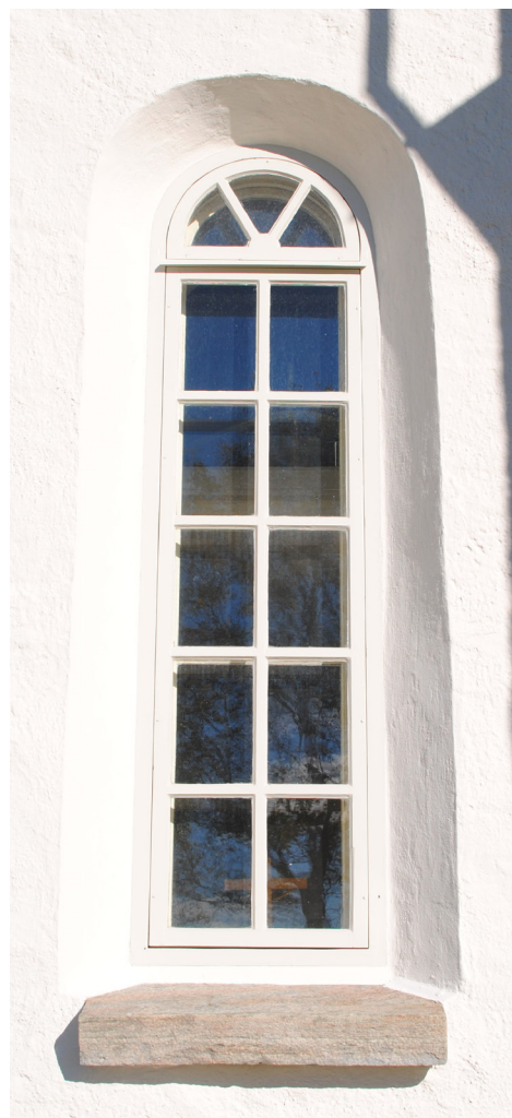
Det ena tornfönstret efter renovering.
