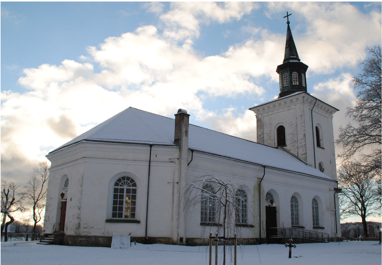
Långskeppet norra fasad och tornet östra fasad innan renovering.
