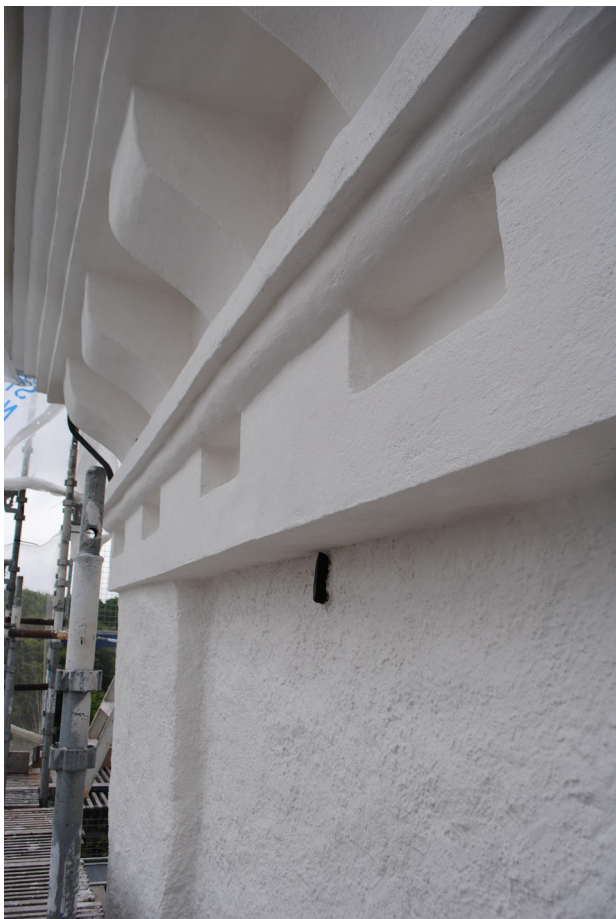
Takgesimsen på tornet efter ommurning av skador i murverket. Den del av det inmurade ankarjärnen som är synlig har målats med svart linoljefärg.
