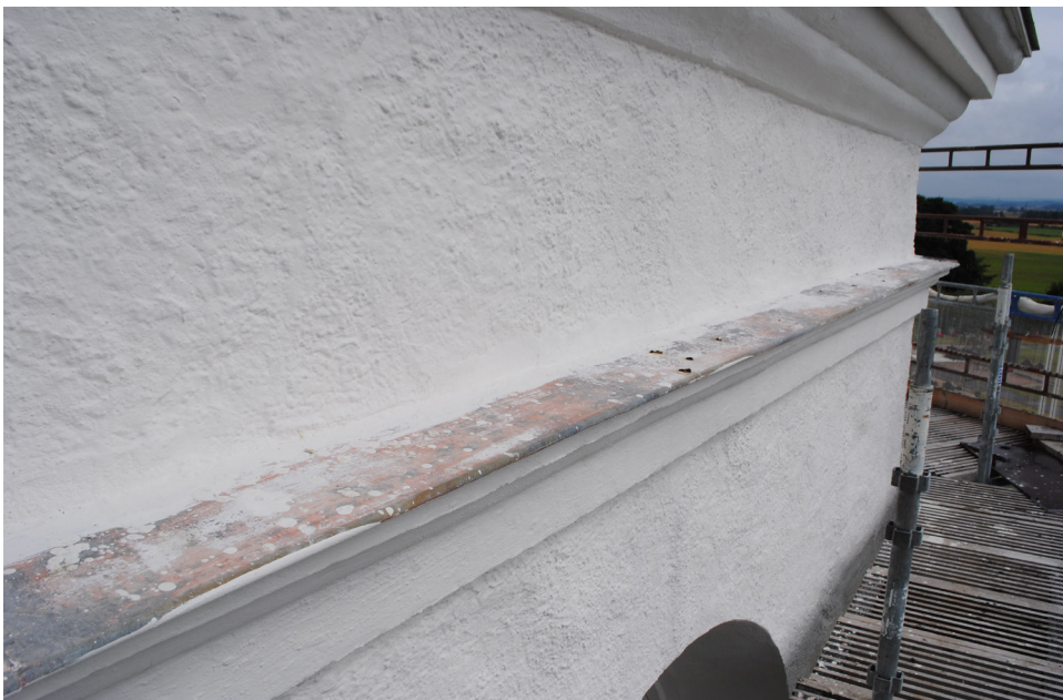
Plåttäckningen på gördelgesimsen på långskeppet var i bättre skick än på tornet och sparades. Den rengjordes och målades.
