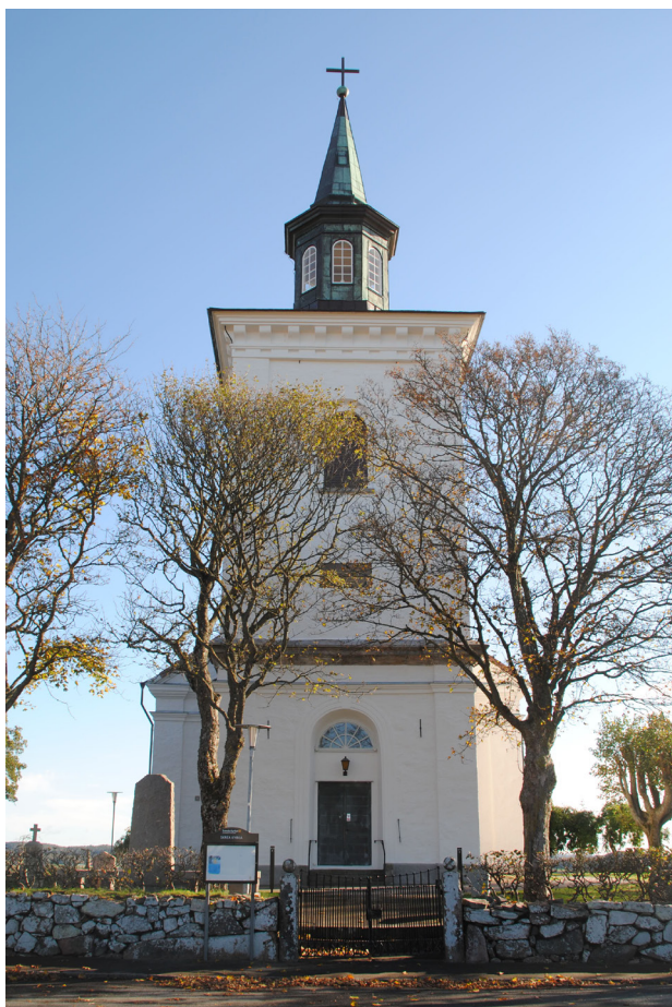
Tornets västra fasad efter renovering.
