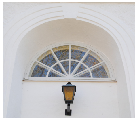
Ovan: Fönstret över södra entrén efter renovering.
